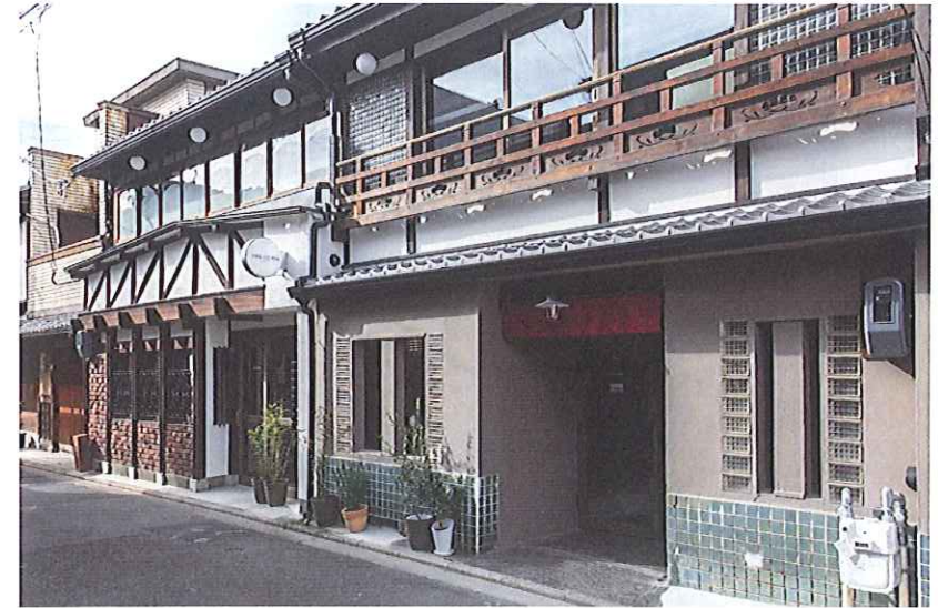
建物外観（改修後）
