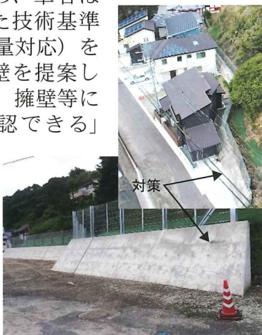
民間資金による土砂災害防止対策工事
